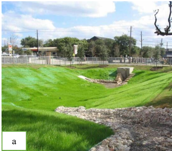
Рисунок 2 – Примеры устройства бассейнов удержания (а – бассейн удержания типа «сухой пруд», б – бассейн удержания типа «мокрый пруд»)
