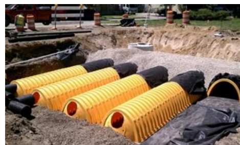
Рисунок 19 – Примеры устройства подземных накопителей
