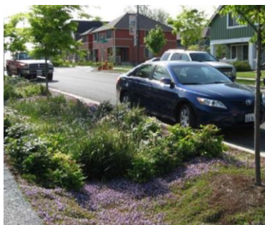
Рисунок 24 – Примеры устройства фильтрующих траншей
