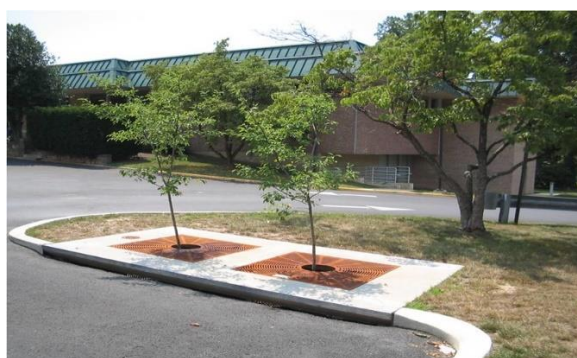
Рисунок 37 – Примеры устройства коробчатых фильтров с посадкой деревьев
