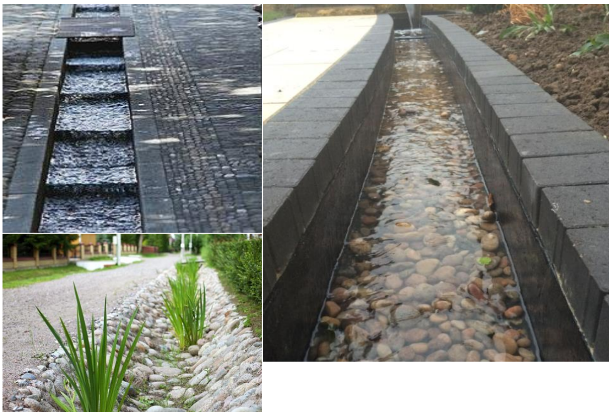
Рисунок 16 – Примеры устройства придорожного канала
