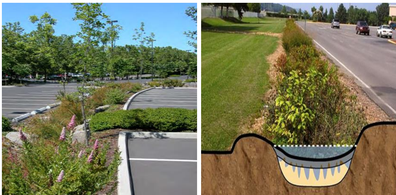
Рисунок 11 – Примеры устройства растительных каналов
