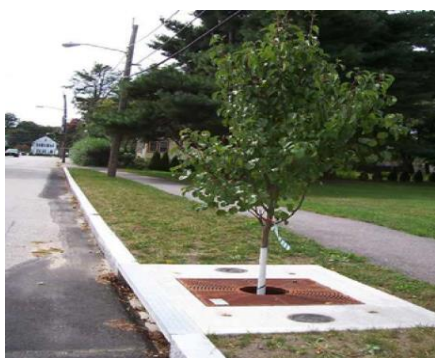
Рисунок 37 – Примеры устройства коробчатых фильтров с посадкой деревьев
