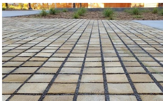
Рисунок 17 – Примеры устройства водопроницаемых покрытий
