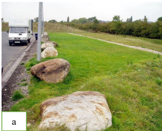
Рисунок 7 – Примеры устройства фильтрующих полос (а – фильтрующая полоса естественного происхождения, б – фильтрующая полоса искусственного происхождения)
