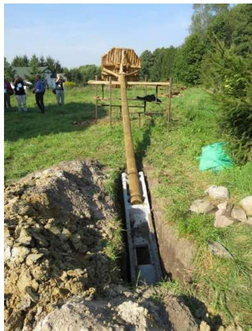
Рисунок 9. Конструкция (бетонное основание, деревянный столб и платформа для гнезда) изготовлены заранее. Также заранее вырыта яма для установки столба.
