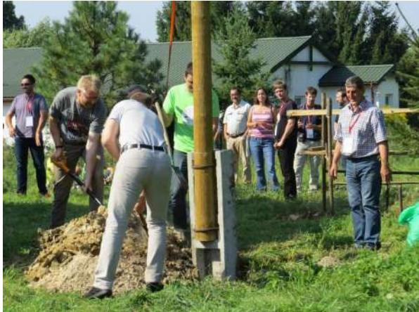
Рисунок 21. Деревянная часть опоры на 20 см выше уровня земли.
